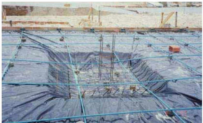
Radier pronto para concretagem, vendo-se capitel sob pilar, e bolachas de concreto para suporte das cordoalhas.
