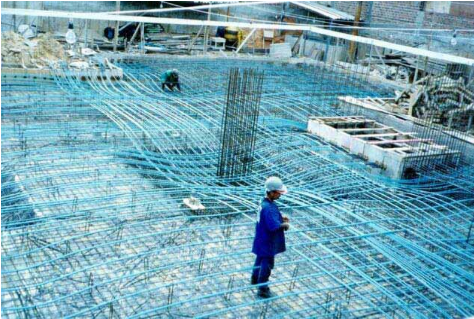
Montagem das cordoalhas na laje, vendo-se os capitéis sob os pilares. Foram usadas 3 ton. de cordoalhas, em laje de aprox. 300 m 2 .
