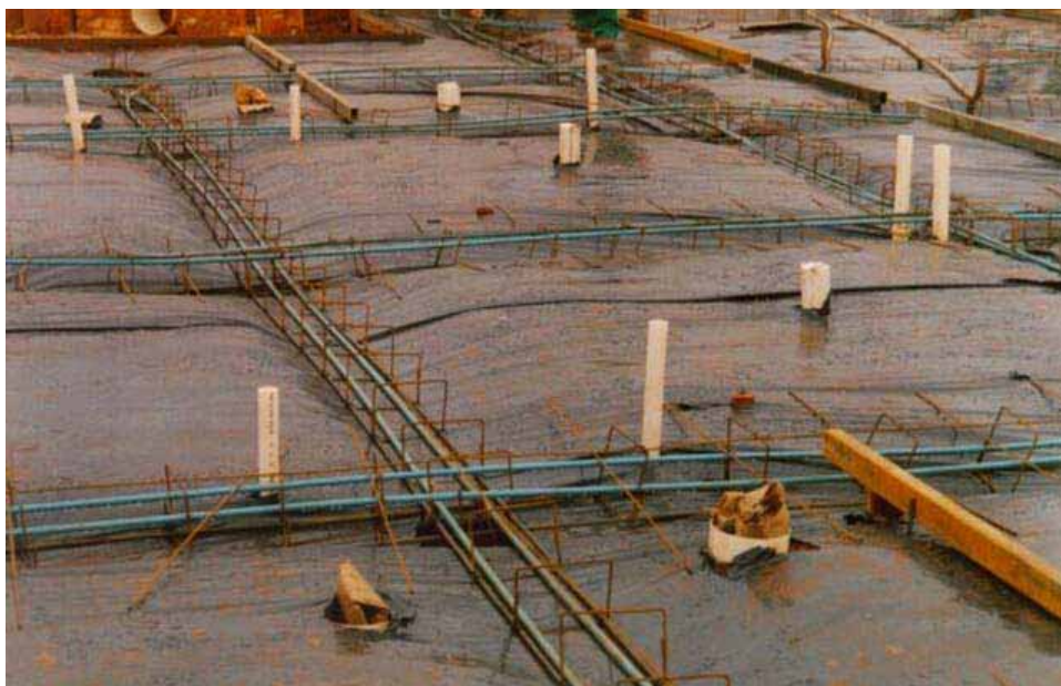
Cabos colocados nas nervuras cavadas no terreno
