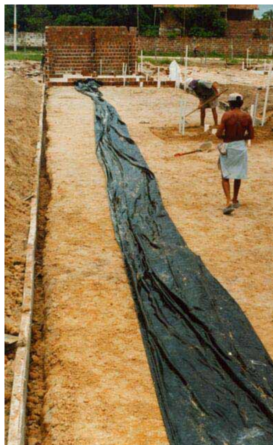
Engrossamento das bordas e colocação de filme plástico para isolamento
