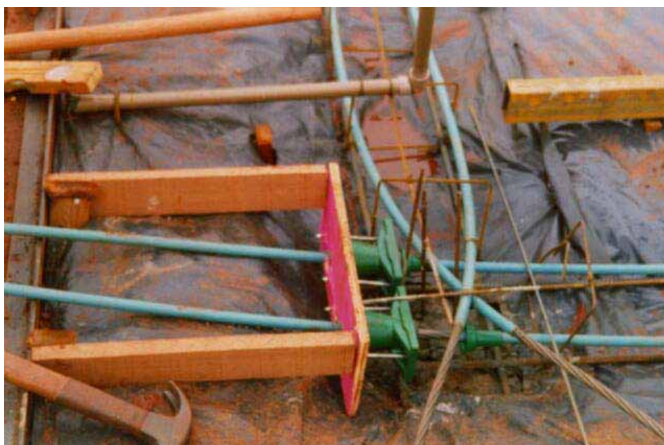
Detalhe das ancoragens em nicho junto a outra laje à esquerda
