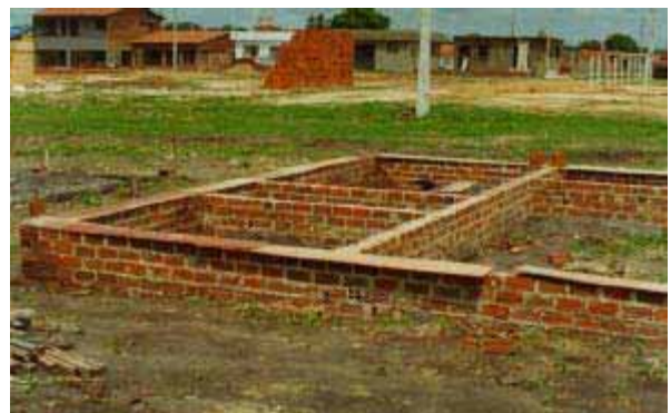
Base de alvenaria de tijolos
