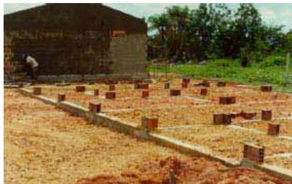
Reatêro apiloado, antes do contrapiso (5cm)
