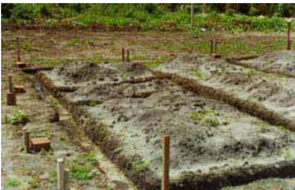
Escavação e nivelamento das valas
