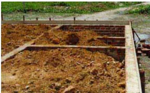
Alvenaria, forma, cinta e reatêro manual
