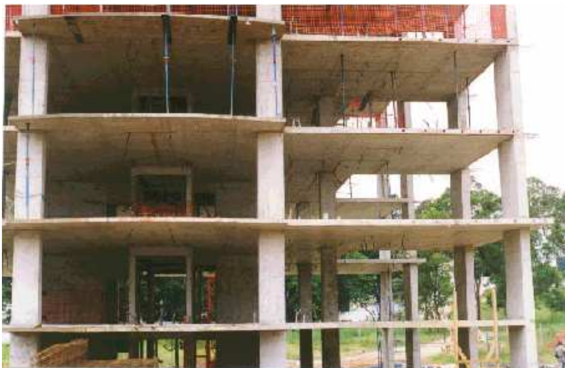
Edifício Residencial sem vigas
