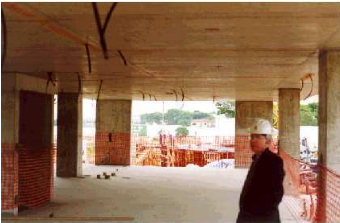
Laje sem vigas e com piso acabado
