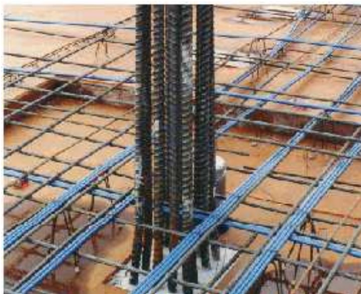
Armação do pilar engarrafada
