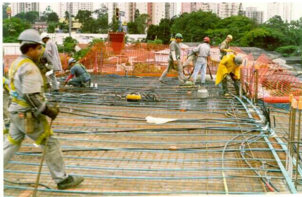
Exemplos de cordoalhas em uma laje
